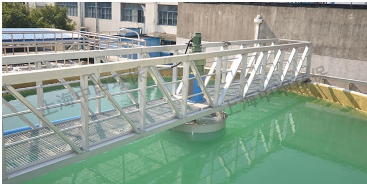
中心传动刮吸泥机的停驻位置应在沉淀池的出水端。驱动前，开启各吸泥管的排泥阀，然后向进水端行进半桥周边传动刮泥机。到达进水口尽端时行车刮泥机，即自动返驶，回至出口端的原位停车，作为一次吸泥的全过程。 泵吸排泥：主要由泵和吸泥嘴、吸泥管组成。吸入管内的污泥经水泵出水管输出池外。吸泥的起动由人工操作，返驶及停车等动作均由装在轨道上的触杆触动行车上的行程开关完成。轨道上触杆的定位，以及行车上行程开关间的相对位置，应在安装时确定。南京中心传动式 刮泥机刮泥机哪里有？认准上海中申环境工程有限公司！
