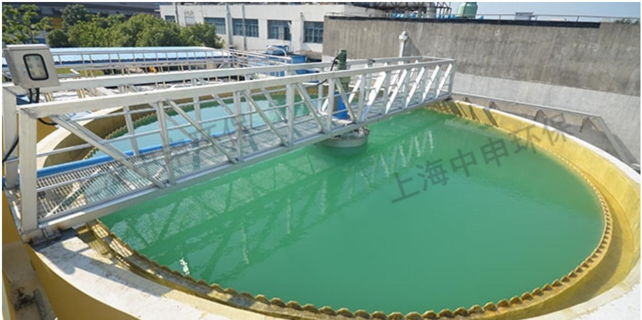
因为多年不断的发展，对各种设备的运用提出了新的要求。因而，在刮泥机的规划和改善上，逐渐转向技能改善。经过对首要形式和结构的改善，能够满意不同环境下的使用需求，更好地进步实用性。经过调理设备的装置和使用，能够合理运用，然后进步其运转能力，减少池水中的污泥堆积。在规划中心刮泥机时要考虑到快速排泥的实践需求，主要是对设备及其传动结构进行改善。经过中心驱动的运转方式，加强了其运转功率。经过简略的结构改善，增加了新的电气设备，使设备能够完成首要任务。此外，经过合理的运转调整，能够下降设备的负荷。中心刮泥机采用中心驱动悬挂式，污水从操作桥下的进水管流入尾水管并分散后，沿径向向外均匀流出。沉积后悬浮污泥沉积在池底，驱动设备驱动中心立轴旋转，驱动翻滚。装置和使用机械设备进行废水处理时，假如发现作业忽然中止，是因为机械设备内堆积的污泥厚度过大形成的。假如长期运转后不准时进行清洗，会有大量污泥堆积在设备内，危及机械设备运转，形成停滞。届时，有必要立即进行清洗，以解决问题。
