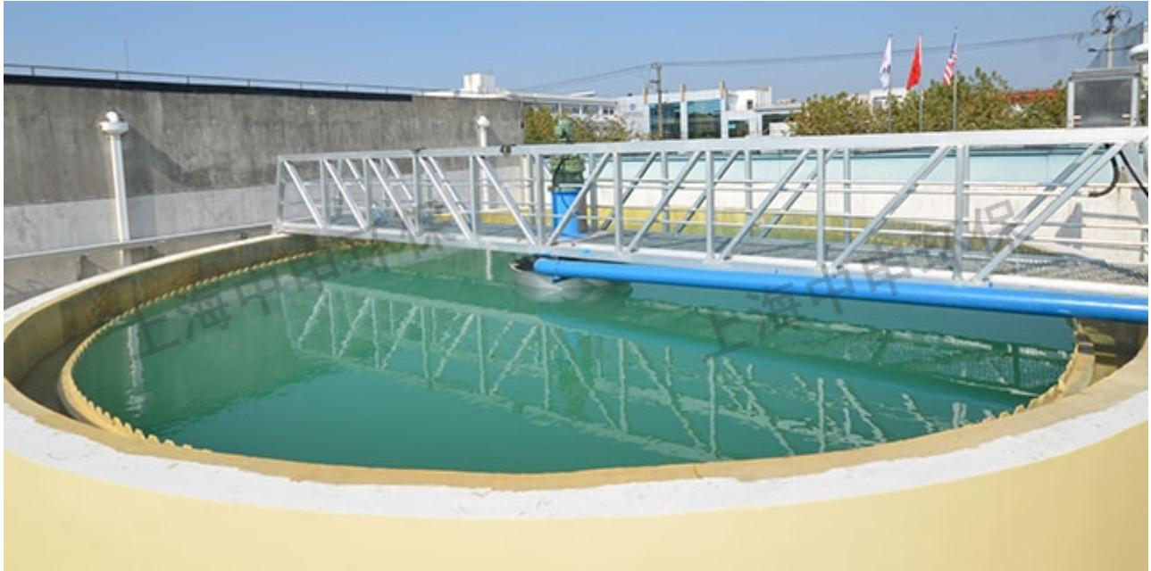
桁车式刮泥机可选用PLC控制，依据必须设计方案污泥浓缩机的全线、一半运作方法。能用时间操纵污泥浓缩机的周期时间，也可附属泥位计检验水池积泥状况自启动。虹吸泥机管上应设与众不同的排泥量调整设备，依据污泥浓缩池水平全自动调节泥量，以节省解决花费。泵吸式或泵虹两吸式选用无堵塞排污泵潜水排污泵，起动快速，不用引水渠设备，实际操作维护保养简易。潜水排污泵与吸泥系统软件连接与众不同，不断水也可对潜水排污泵开展检修拆换。按照结构形式区分的话，回转式刮泥机可以被分为四大类，分别是全跨、与半跨式以及中心驱动式和周边驱动式。不用结构形式的刮吸泥机表现除了不同的特征，这也是需要掌握的知识。如果发现回转式刮泥机桥架的一端与中心立柱上的旋转支座相接，另一端安装驱动装置和滚轮，而且每转一圈刮1次泥，这种形式称为半跨式，适用于直径30m以下的中小型沉淀池。相反，如果刮吸泥机具有横跨沉淀池直径的工作桥，旋转桁架和刮泥板都是对称布置的话，就是全跨式。
